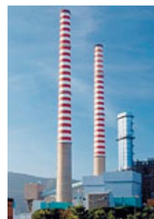
L'ex centrale. /METRO
